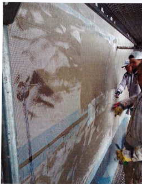
▲ Bild 10 • Fassade im Ausgangszustand (oben links), Fassade mit Kapillarrohrmatten der Wandtemperierung (oben rechts). Einputzen der Kapillarrohrmatten (Mitte links). Aufkleben der Wärmedämmung (Mitte rechts) und Armierung der Fassade (unten links). Fassade im sanierten Zustand (unten rechts). Bildquelle: IZES gGmbH
