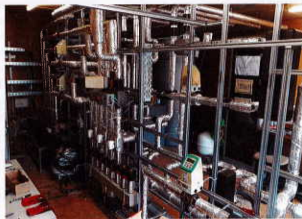
▲ Bild 13 • Dach mit den PVT-Hybridkollektoren (oben links). Foto der Rückseite der PVT-Kollektoren mit Aufständigung und Beschwerung (oben rechts). Eisspeicher in der unverfüllten Baugrube (Mitte links). Baufeld mit Eisspeicher nach der Verfüllung, zu sehen ist nur noch der Elektro-Verteilerkasten (Mitte rechts). Technikzentrale im Bauzustand mit ankommenden Erdleitungen, Wärmepumpe und Pufferspeicher (unten links). Blick in die fertige Technikzentrale mit der Hydraulik-Verteilung und MSR-Technik (unten rechts). Bildquelle: IZES gGmbH
