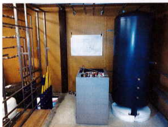
▲ Bild 13 • Dach mit den PVT-Hybridkollektoren (oben links). Foto der Rückseite der PVT-Kollektoren mit Aufständigung und Beschwerung (oben rechts). Eisspeicher in der unverfüllten Baugrube (Mitte links). Baufeld mit Eisspeicher nach der Verfüllung, zu sehen ist nur noch der Elektro-Verteilerkasten (Mitte rechts). Technikzentrale im Bauzustand mit ankommenden Erdleitungen, Wärmepumpe und Pufferspeicher (unten links). Blick in die fertige Technikzentrale mit der Hydraulik-Verteilung und MSR-Technik (unten rechts). Bildquelle: IZES gGmbH
