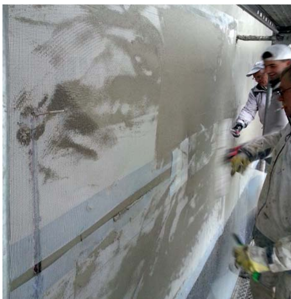
Bild 2: Fassade im Ausgangszustand (oben links), Fas- sade mit Kapillar- rohrmatten der Wandtemper- erierung (oben rechts), Einputzen der Matten (Mitte links), Aufkleben der Wärmedäm- mung (Mitte rechts), Armierung (unten links) und Fassade im sanierten Zustand (unten rechts) © IZES gGmbH
