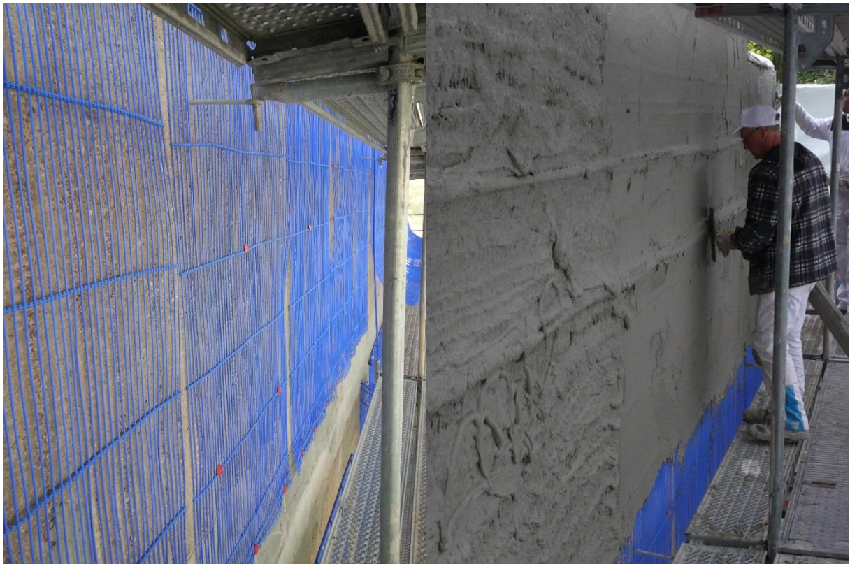
Abbildung 4: Kapillarrohrmatten der aWT auf der Feldtestfassade (links). Einputzen der Kapillarrohrmatten mit 10 mm Klebemörtel (rechts) [Bildquelle: IZES gGmbH].
