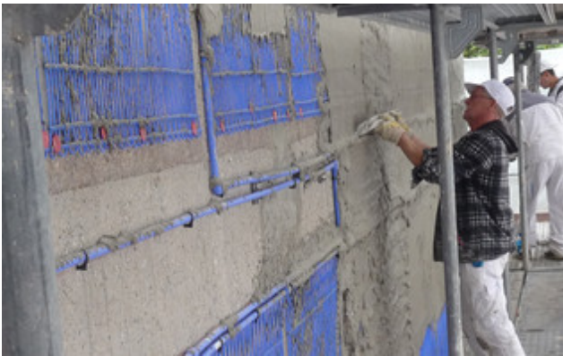
Bei einem Sanierungsprojekt kann nun erstmals eine Flächenheizung außen unter einer Dämmung angebracht werden. Die Kapillarrohrmatten (im Bild) werden dabei auf die Betonfassade aufgebracht und mit Klebemörtel eingeputzt. © IZES gGmbH
