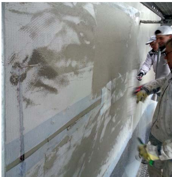
Bild 2: Fassade im Ausgangszustand (oben links), Fassade mit Kapillarrohrmatten der Wandtemperierung (oben rechts), Einputzen der Matten (Mitte links), Aufkleben der Wärmedämmung (Mitte rechts), Armierung (unten links) und Fassade im sanierten Zustand (unten rechts) © IZES gGmbH
